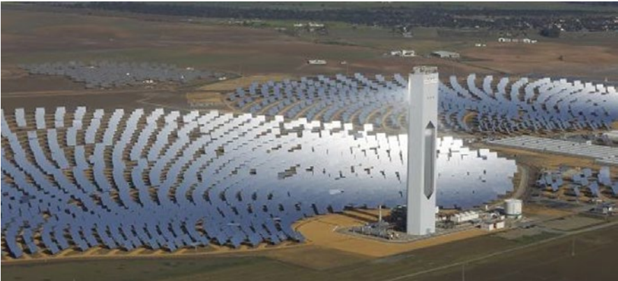
FIGURA 3.13 | Central de torre situada en Sanlúcar la Mayor, Sevilla
