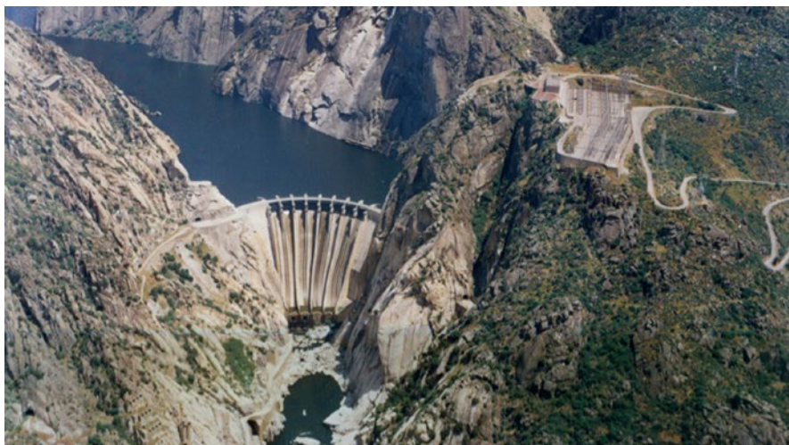
FIGURA 3.7 | Foto de la central hidráulica de presa (y regulación) de Aldeadávila
