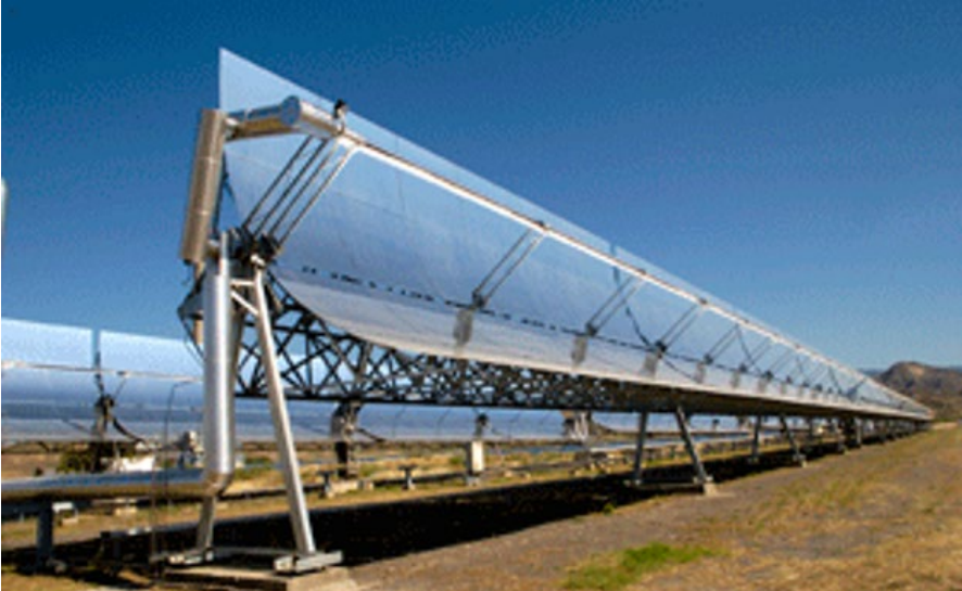
FIGURA 3.12 | Instalación de colectores cilindro-parabólicos, [3.28]
