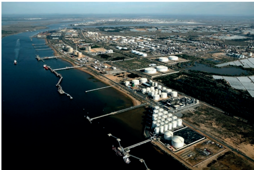
FIGURA 2.8 | Parque Energético de Moeve, en Palos de la Frontera (Huelva)
