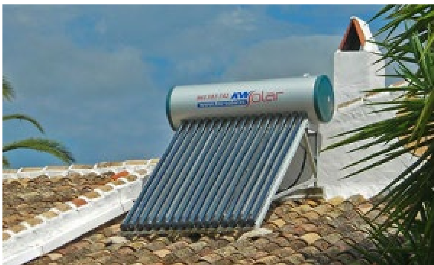
FIGURA 3.11 | Equipo compacto de solar térmica a baja temperatura
