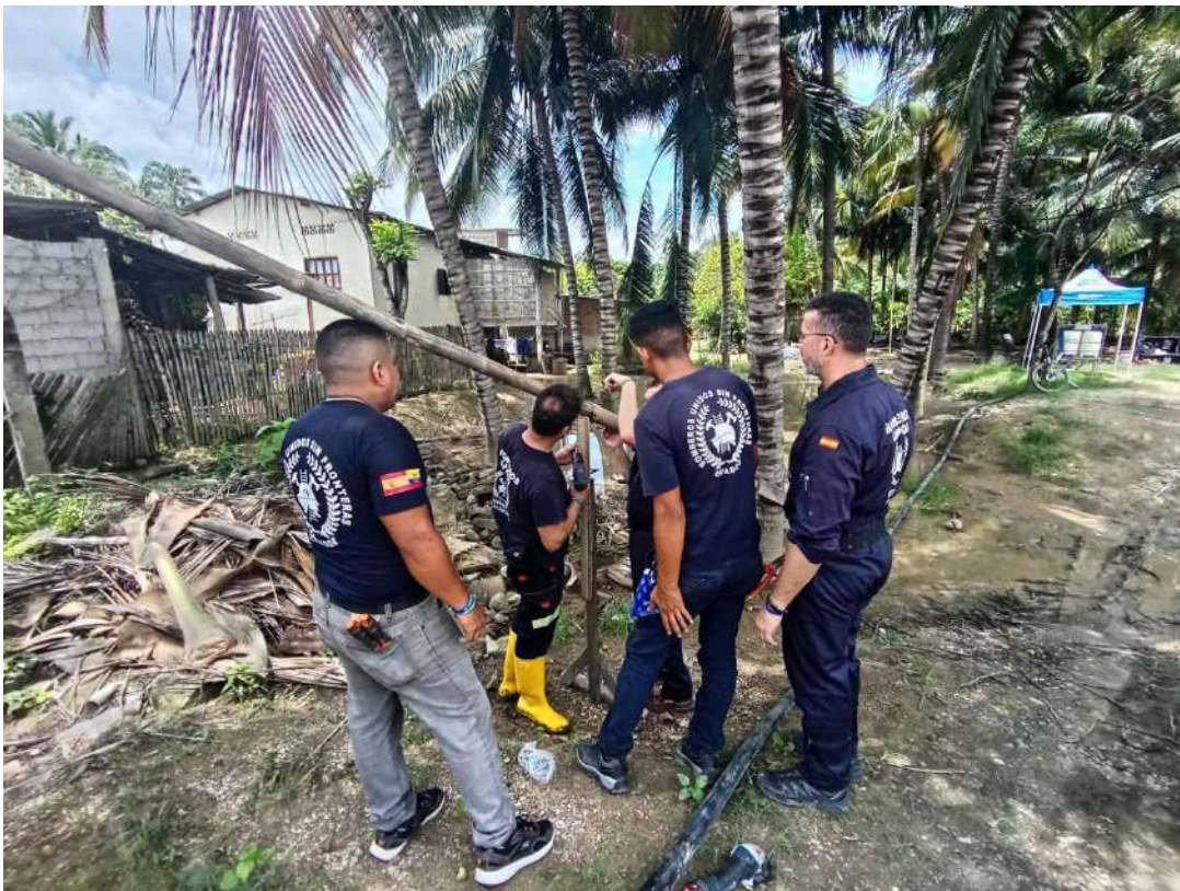
Trabajo en terreno de Adolfo en Ecuador, 24/03/2025. Fuente: Álbum fotográfico personal.
